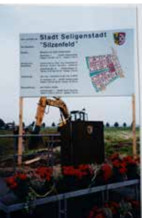
Spatenstich für das Neubaugebiet Silzenfeld.
